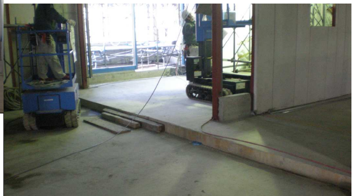
ここが中央図書館の入口。エスカレータ口です。写真だけでは、まだまだ分からないので、もう少し工事が進んで、ドアが出来るのを待ちましょう。
