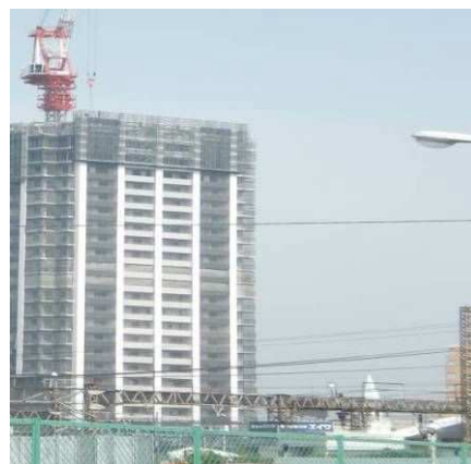
遠くからでもわかる工事現場
