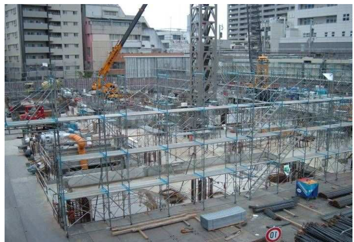
現在は地下工事が進行中です
