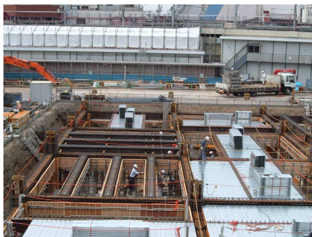
着々と工事が進む現場
