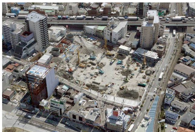
更地になった建設予定地
