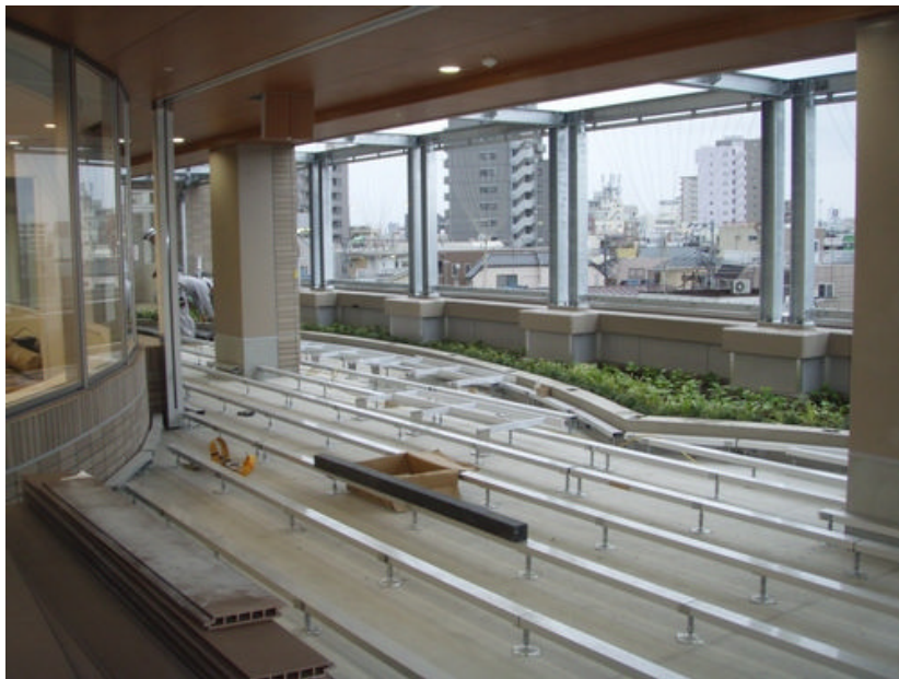
④こどもデッキにも梁が張られてきました。ここでも本が読めます。
