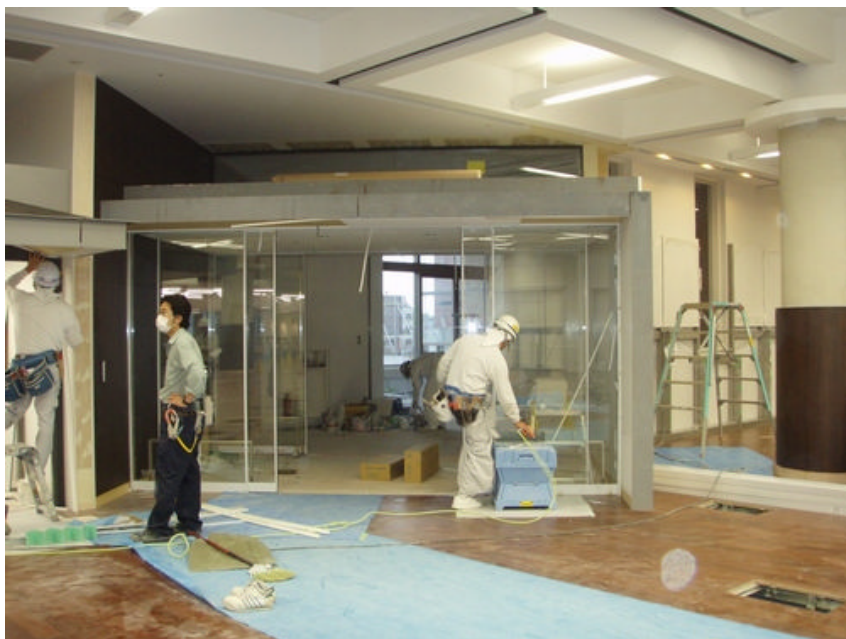
⑧エスカレーター側の入口です。だいぶ雰囲気が出てきました。
