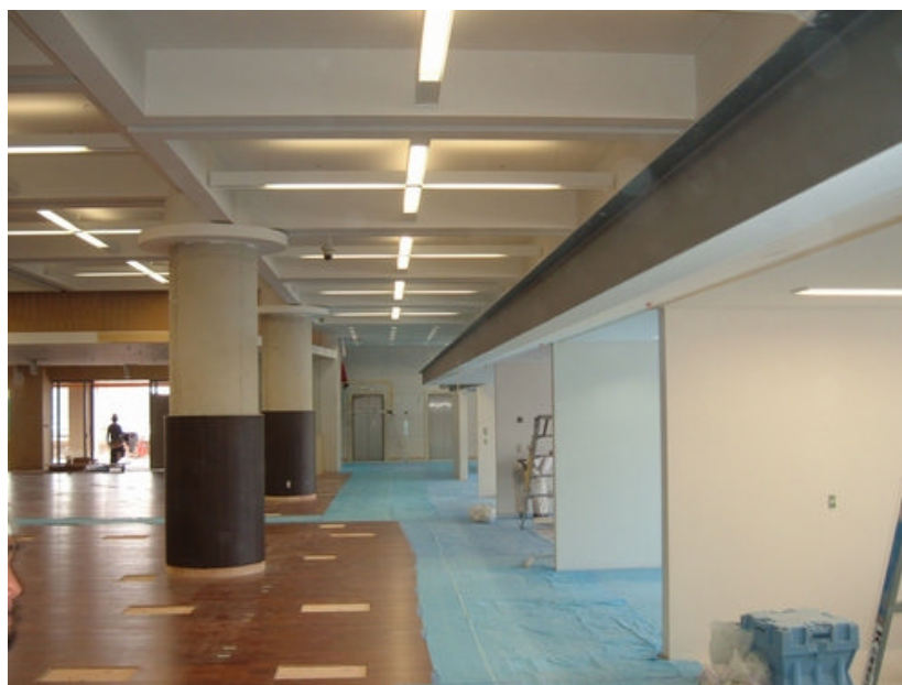
①壁や柱の塗装も仕上がってきました。
