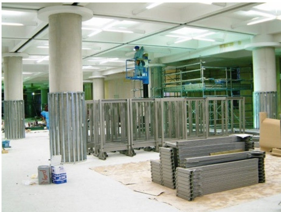
③一般書エリアからエスカレーター側入口を撮影。照明も入り、明るい雰囲気伝わってきます。
