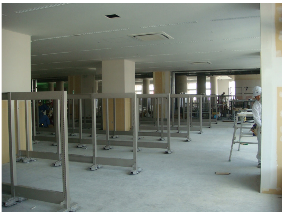
⑤一般書エリア（高層棟）を撮影。高層棟部分は角柱になります。奥に低層棟部分の丸柱が見えます。
